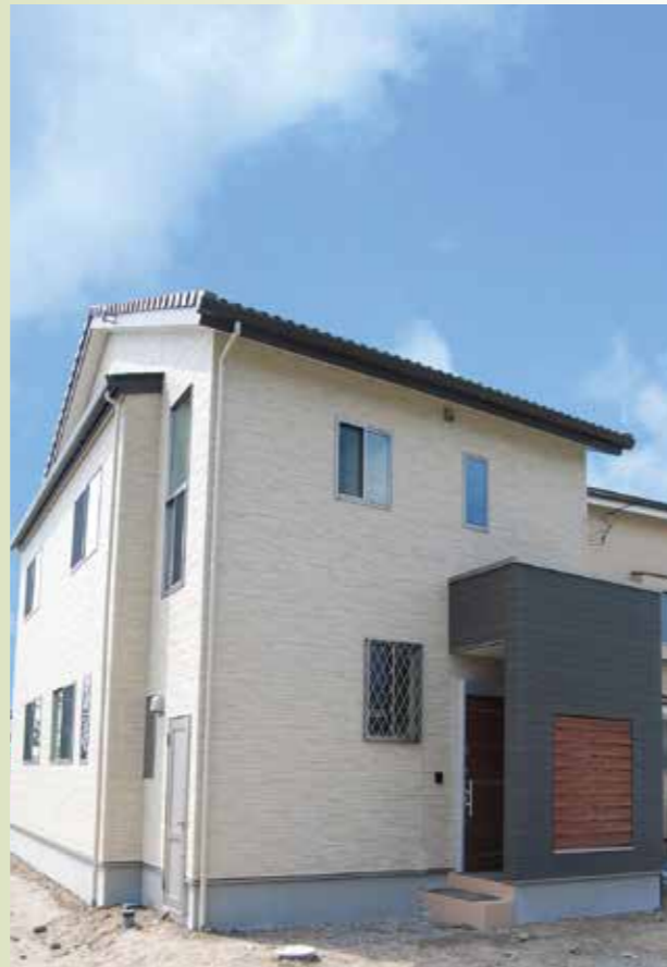
▲縦長の土地を活かした外観デザイン
