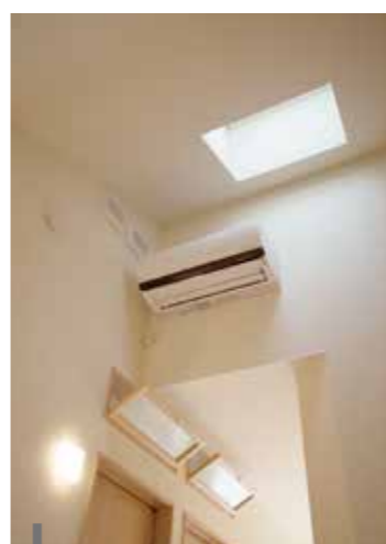
パッシブ換気 天窓・排気煙突・ランマが自然な空気の流れをつくります。
