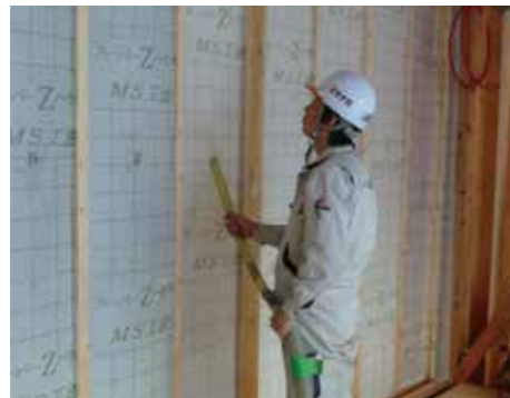
セルローズファイバー断熱材施工風景
